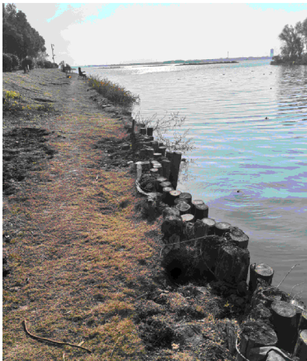
现状木桩护岸
